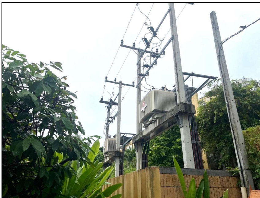
ภาพที่ 52 แสดงหม้อแปลงไฟ ฟัง บ้านพักชายทะเลใช้ร่วมกับฟัง โรงแรมวีริ์นดา จำนวน 2 เครื่อง
