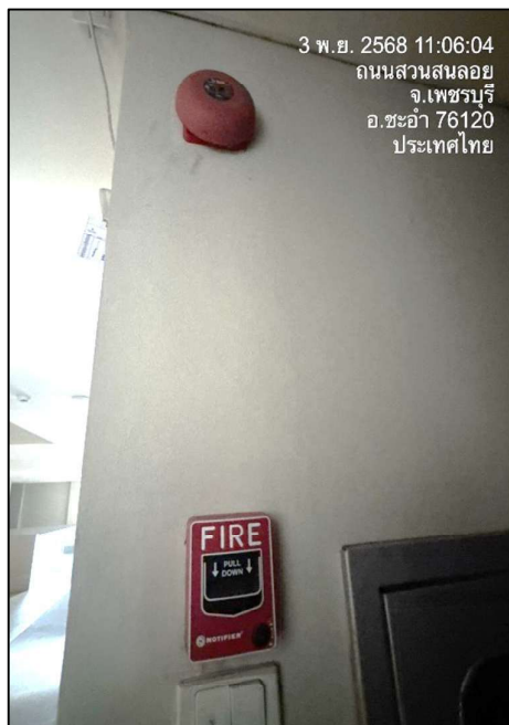
ภาพที่ 26 แสดงอุปกรณ์แจ้งเหตุเพลิงไหม้ (Fire)
