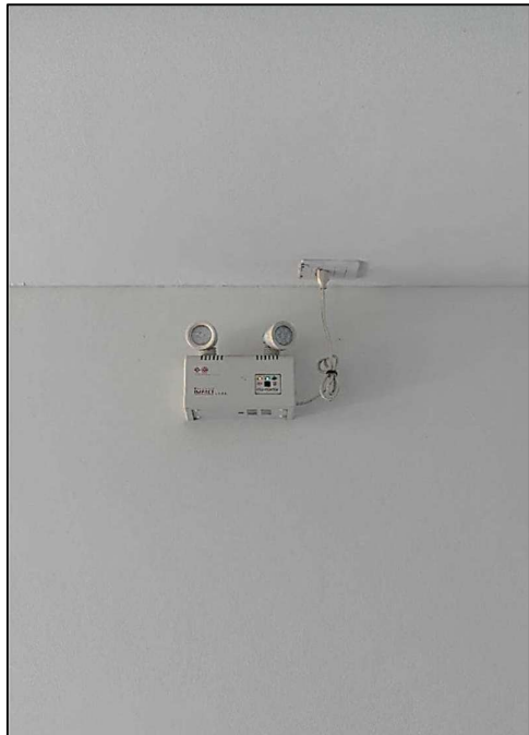
ภาพที่ 29 แสดงไฟส่องสว่างฉุกเฉิน
