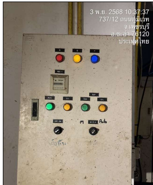
ภาพที่ 49 แสดงตู้คอนโทรลควบคุมการทำงานของเครื่องเติมอากาศ
