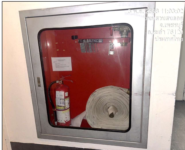
ภาพที่ 27 แสดงตู้เก็บสายน้ำดับเพลิง-ถังดับเพลิง
