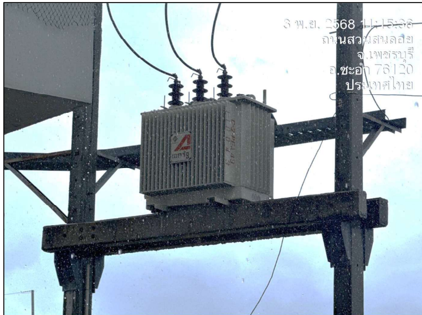
ภาพที่ 51 แสดงหม้อแปลงไฟ ฟัง โรงแรมหัวหินพูลสวิต จำนวน 1 เครื่อง
